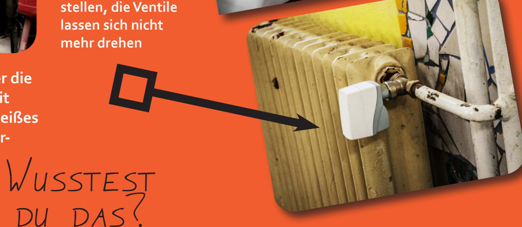
Vom Hausmeister haben wir uns im Heizungskeller die Heizanlage erklären lassen. Unsere Schule wird mit **Fernwärme** beheizt. Das heißt, es wird **110 Grad heißes Wasser** in die Schule gepumpt. Dieses Wasser überträgt seine Wärme an das Wasser, das im Heizkreislauf der Schule zirkuliert und mit **70 Grad** durch die Rohre in alle Heizkörper geschickt wird.
