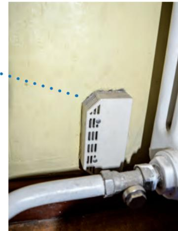
Das Problem ist das der Sensor zu nah an der Heizung ist und dann denkt es ~~zu~~ wär zu k. Ihn schaltet die Heizung runter. Deswegen ist alles so kalt
