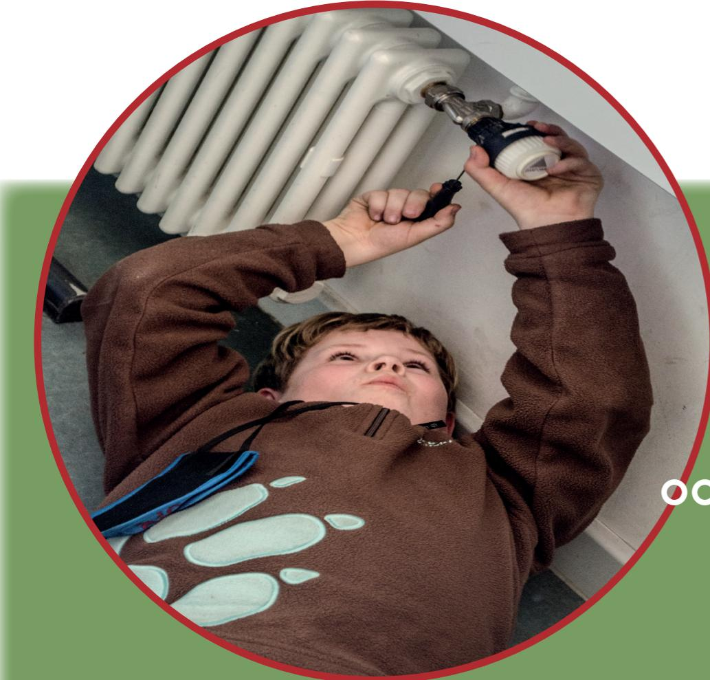
*Die „Energiemanager“ blockieren die Heizungsthermostate in den Klassenräumen, damit sie nicht zu hoch aufgedreht werden. Um die Temperaturen in den Klassen zu überprüfen, setzen sie Messgeräte ein, die die Daten aufzeichnen.*
