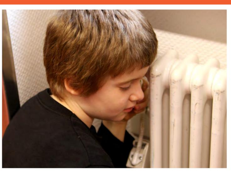
Beim **Ventil-Check** hören wir die **Heizung** auch ab, um festzustellen, ob Strömungsgeräusche zu hören sind. Hier versucht es Tim ohne **Stethoskop**, aber einfacher ist es mit.
