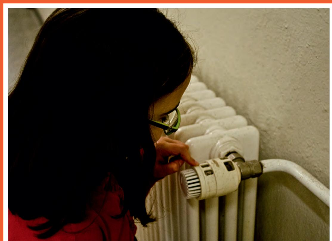
Da die Heizkörper in den Fluren nicht zentral am Computer gesteuert werden, müssen alle Thermostatventile von Hand eingestellt und fixiert werden.
