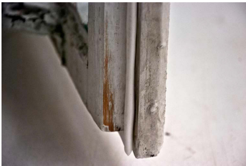
Detailansicht der Fensterdichtung. Es handelt sich um Schlauchdichtungen aus einem Silikon-Kautschukgemisch, die in eine vorgefräste Nut eingepasst werden.
