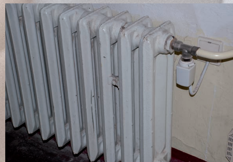
Unsere Heizungen haben ein Ventil, welches der Hausmeister am Computer zentral steuert.
